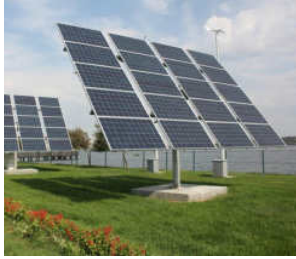
İBB-Küçükçekmece Tracker (Güneş Takipli) Güneş Enerjisi Santrali
